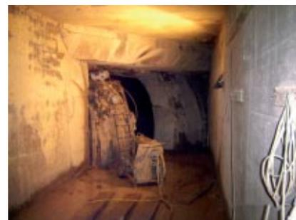
**FIG. 16:** PIANTE DELLA GALLERIA DI CONFLUENZA NELL'ARENA S. ANTONIO CON INDICAZIONE DEL SISTEMA DI PROTEZIONE DELLE OPERAZIONI DI SCAVO (INFILAGGI E CENTINE) – OPERAZIONI DI TAGLIO PER L'APERTURA DELLA FINESTRA DI CONFLUENZA NELL'ARENA S. ANTONIO
