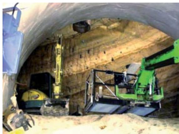
**Fig. 12:** ESECUZIONE DELLE OPERAZIONI DI CASSERATURA E SCAVO CON PIANO DI LAVORI A QUOTA 6,50 RISPETTO AL FONDO DELLA GALLERIA DI VALLE
