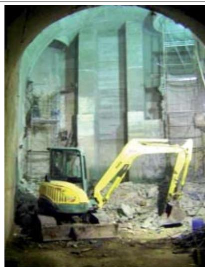
**Fig. 13:** CANTIERI LAVORI DI AMPLIAMENTO DELLA CAMERA DI DISSIPAZIONE AL PIEDE DEI POZZI A VORTICE
