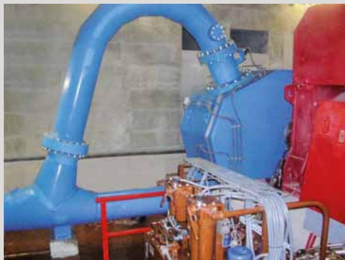
▲ ECOWATT srl - Pruebas del buen funcionamiento de las turbinas en la central hidroelèctrica Val Rezzo (2006)
